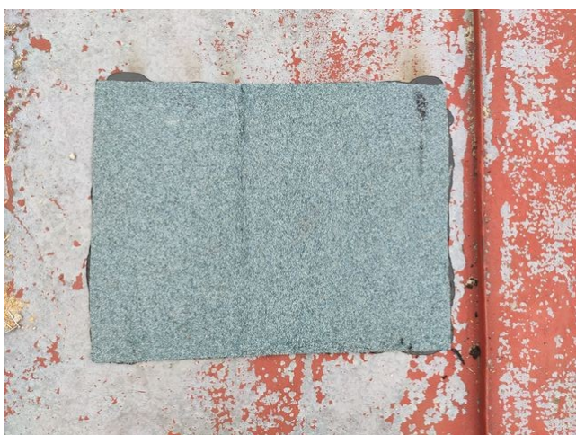
foto/15/ Pohled na zapravenou sondu S4
