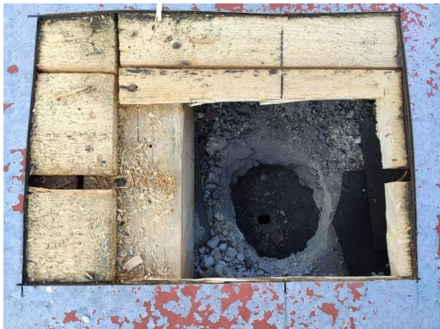
foto/6/ Pohled na provedenou sondu S2
