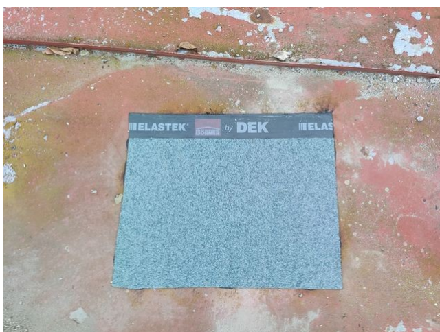
foto/4/ Pohled na zapravenou sondu S1
