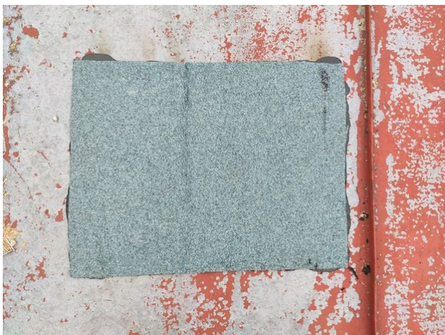
foto/8/ Pohled na zapravenou sondu S2
